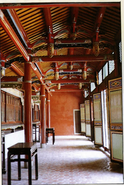
西廡室內景觀，屋架用料較簡單，彫飾亦較少。神龕內供奉先儒與先賢神位。
