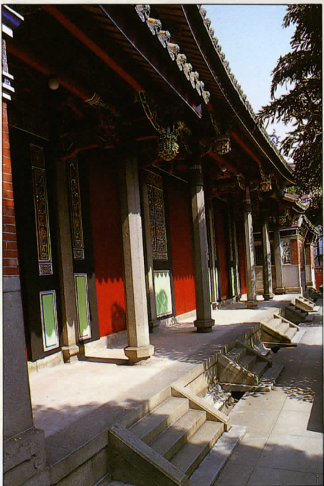
儀門面寬五間，前有廊，柱子為八角石柱，修長而簡潔，成列排開，具有節奏性。
