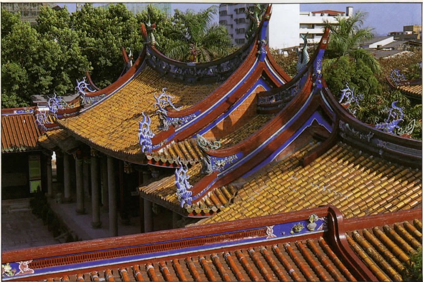
儀門的屋頂使用重簷歇山式，屋脊曲線豐富，交織成一組變化多端的屋頂。
