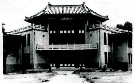
完工於民國四十五年之明倫堂（上）本身雖 為偏向北方式建築，建築立面以西方現代簡 潔、仿復古樣式的窗櫺。
